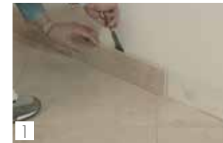
1 Eliminare il battiscopa Remove skirting
